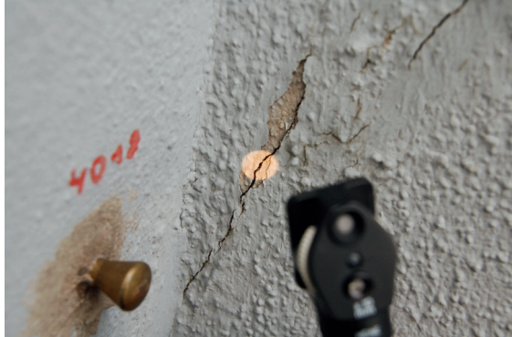
Abb. 3.6.42 Höhenbezugspunkt und Rissprüfung mit Risslupe (Quelle: R. Schöwer)
