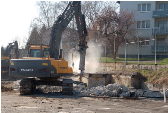
Abb. 3.6.4.3 Meißelarbeiten an Betonbauteilen und Fundamenten (Quelle: R. Schöwer)
