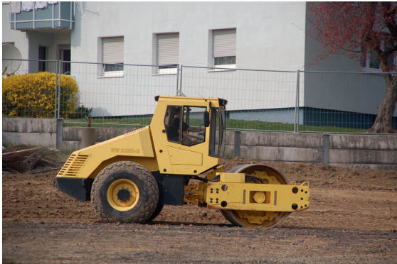
Abb. 3.6.4.4 Dynamische Verdichtung von Bodenauffüllungen (Quelle: R. Schöwer)
